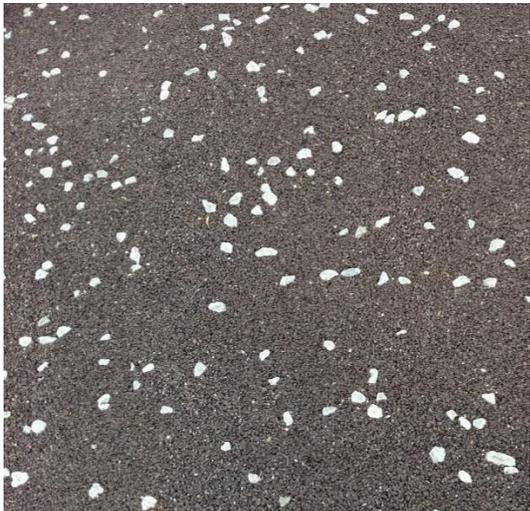
Abbildung 11 (oben): Asphaltbelag mit Split
