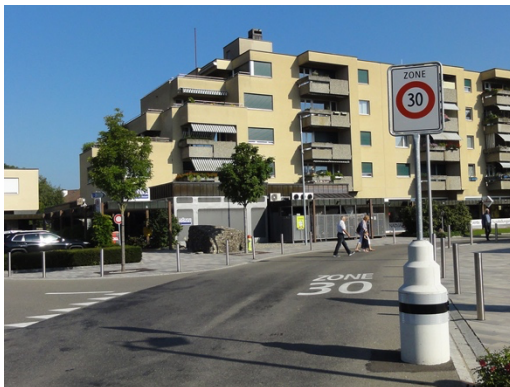
Abb. 10. Eingangstor mit Poller (links) und Stele auf baulicher Einengung mit Abweislinie (rechts)
