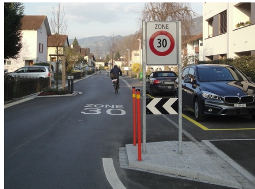
Abb. 10. Eingangstor mit Poller (links) und Stele auf baulicher Einengung mit Abweislinie (rechts)
