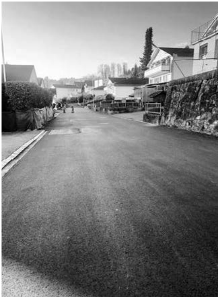
Brauereistrasse mit neuem Deckbelag
