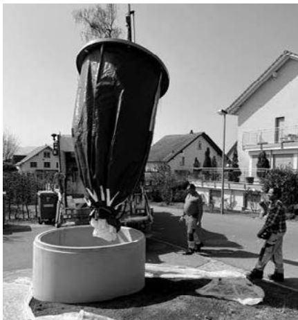
Hebung eines Unterflur-Sackbehälters mit Kran
