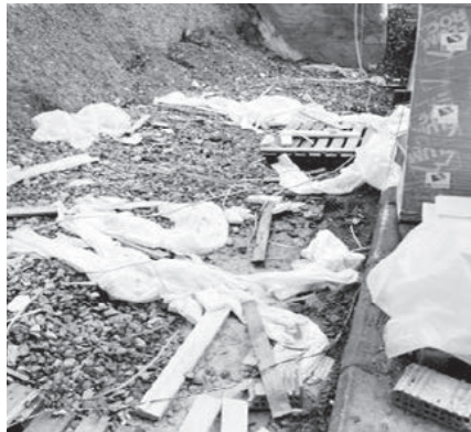
Sauberkeit auf Baustellen
