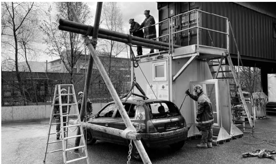
Hilfskonstruktion zum Heben von Lasten...
