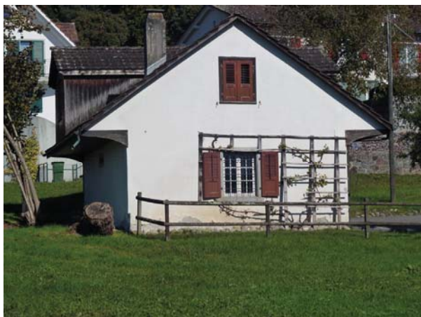
ehem. Waschhaus (Ass. 222), Südansicht
