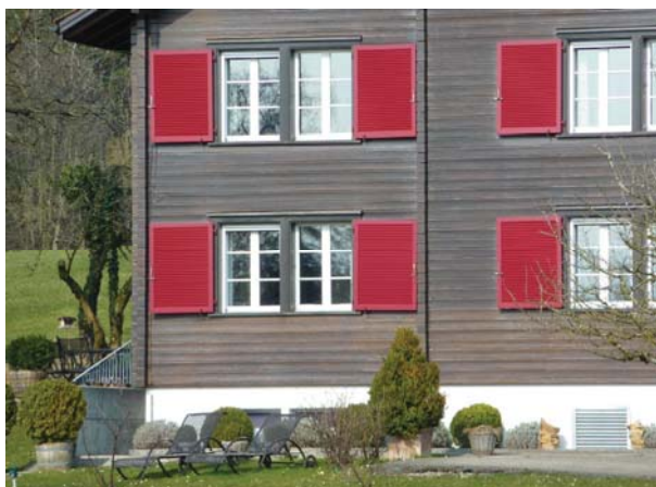
Detailansicht Hauptfassade Wohnhaus
