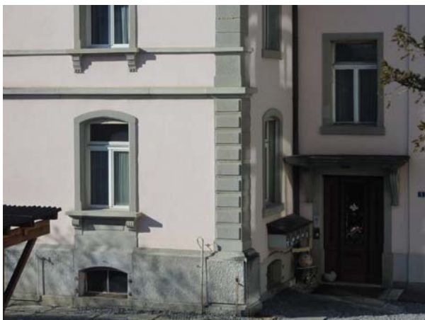
Fassadendetails und Hauseingang Ostfassade
