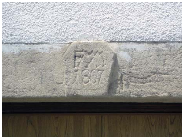
Umfassungsgewände Hauseingang mit Schlussstein
