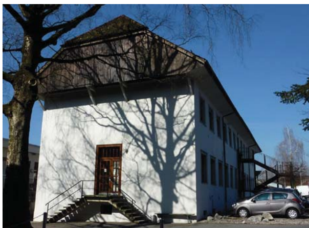
Bürogebäude Ass. 652, Ostfassade
