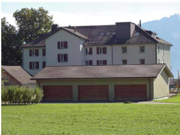
Rückfront Hauptbau und Nebenbauten
