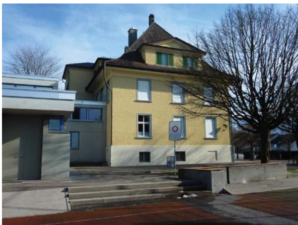
Westansicht mit rückwärtiger Erweiterung
