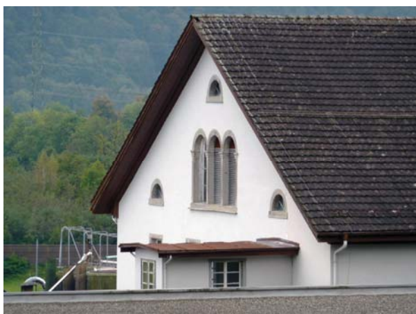
Rundbogenfenster und Lünetten in den Giebelndreiecken
