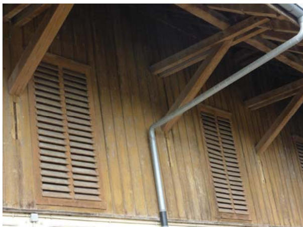
Detail Obergeschoss Ostfassade Ass. 61
