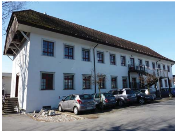
Bürogebäude Ass. 652, Nordfassade
