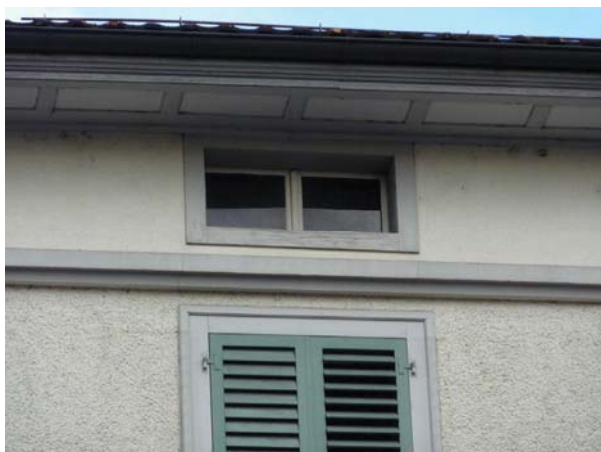
Kniestock und Dachuntersicht
