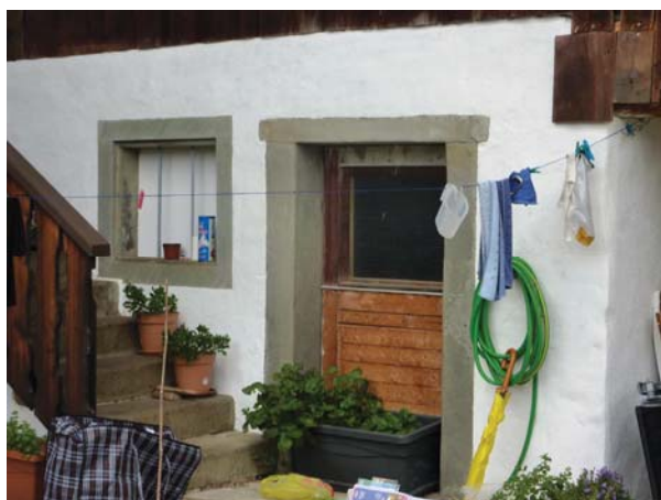
Tür- und Fenstergewände Scheune, Sandsteintreppe
