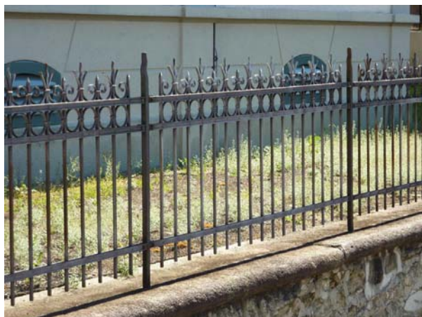
Sockelgeschoss Nordseite und Vorgarten zur Obergasse
