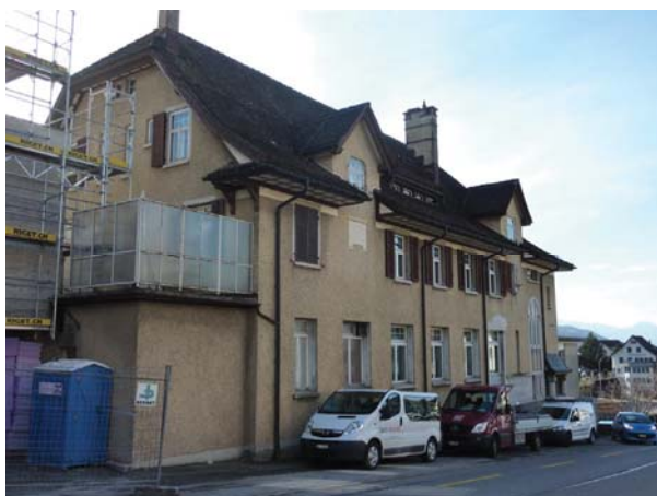
Ansicht Rückfassade Rickenstrasse
