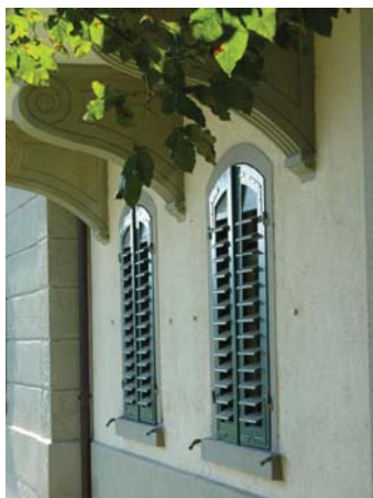
Sockelgeschoss Südseite und Balkonuntersicht
