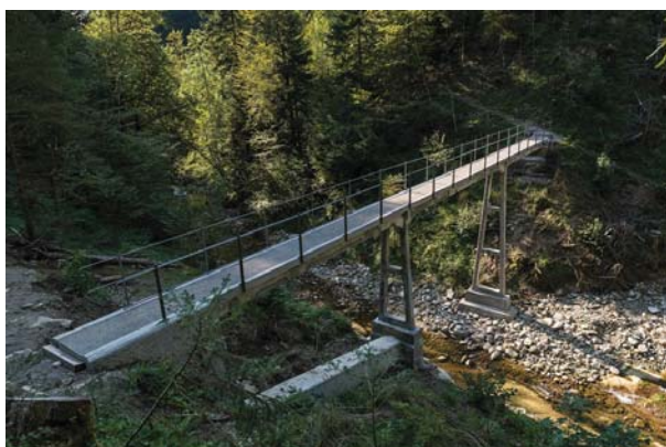
Brücke nach der Sanierung, September 2015
